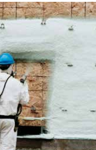
Isolation extérieure continue à cellules fermées Mousse giclée Airmétic Soya HFO
