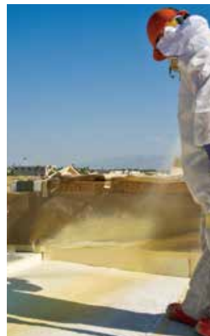
Application de la mousse en toiture
