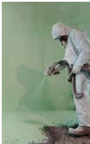
Application sous la dalle - Mousse giclée à cellules fermées Airmétic Soya HFO (protection contre le radon)
