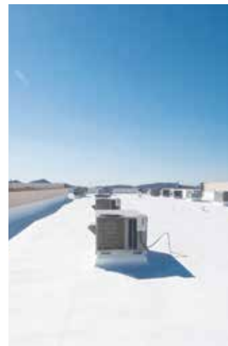
Mousse de toiture avec revêtements
