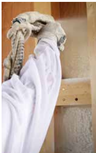
Application de la mousse à cellules ouvertes sur les murs
