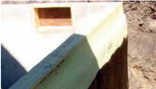
Revêtement bitumineux appliqué directement sur la mousse.
