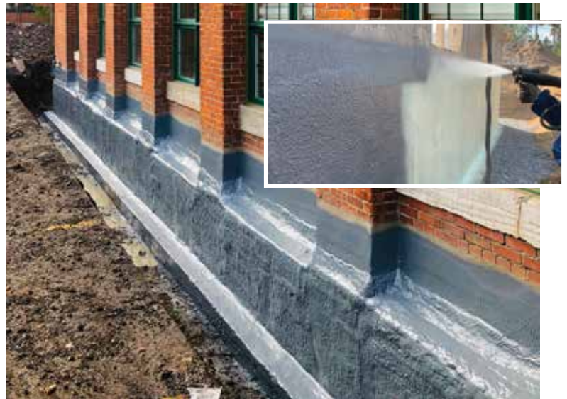
Membrane de drainage qui sera soulevée devant la mousse lors du remblayage du sol.
