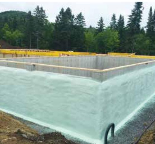
Isolation continue avec la mousse giclée à cellules fermées
