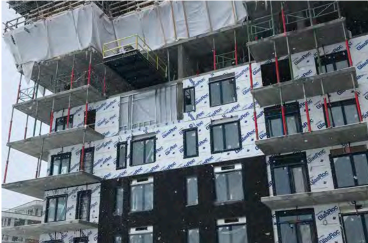
Exemple de productivité du système D-Max. Les parements sont installés du rez-de-chaussé au 3ème étage, on isole de l'intérieur au niveau 3 et 4 et on coule la structure au niveau 6 et 7.
