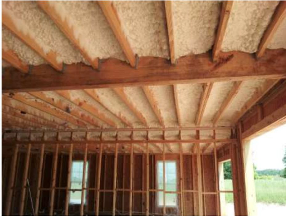
**Figure 1. Exemple où le produit peut servir de barrière thermique appliquée sur l'isolant en mousse de polyuréthane pulvérisée de densité moyenne posé dans les cavités du plafond (et les solives)<sup>(1)</sup> d'un garage à ossature de bois. Dans la photo, la mousse isolante n'a pas encore été protégée par la barrière thermique offerte par le produit DC 315.**
