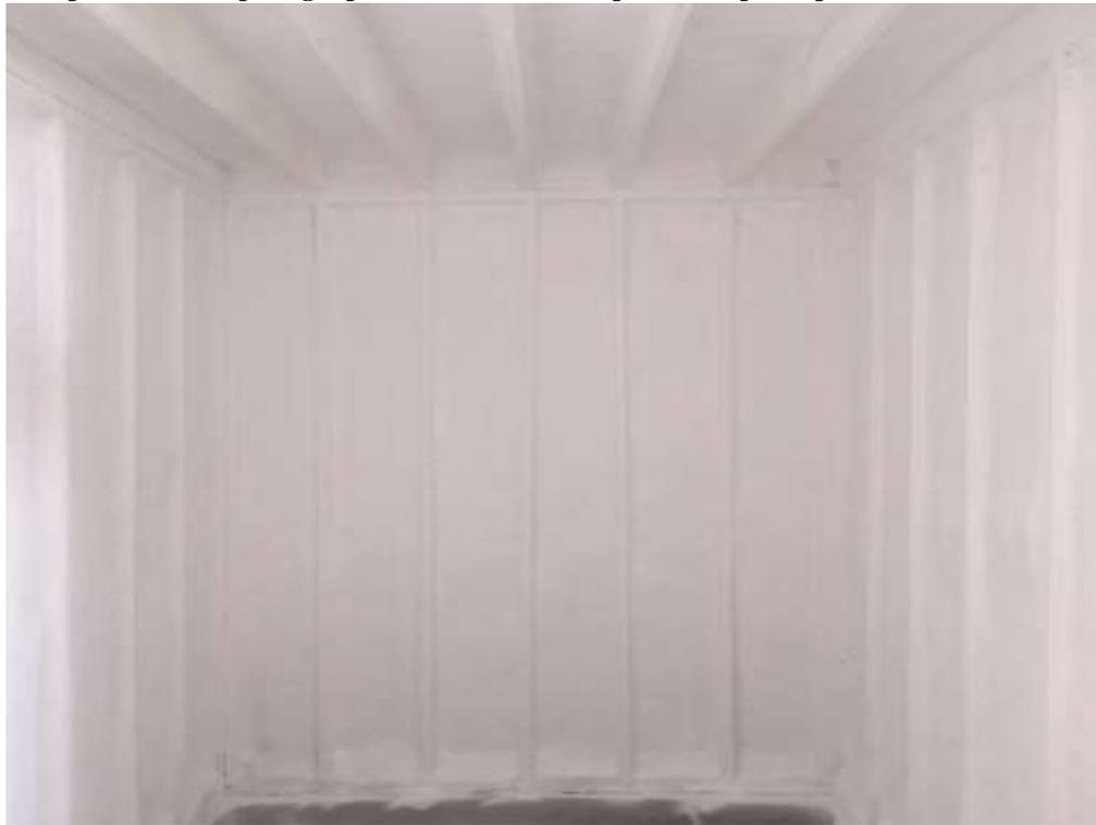
**Figure 2. Exemple où le produit (de couleur blanche) sert de barrière thermique appliquée sur l'isolant en mousse de polyuréthane pulvérisée de densité moyenne posé dans les cavités (et sur les poteaux et les solives exposées)<sup>(1)</sup> dans l'ossature en bois des murs et du plafond d'un sous-sol.**
