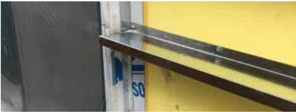
**5.** Installation d'attaches à briques ou de barres en pour le parement.
