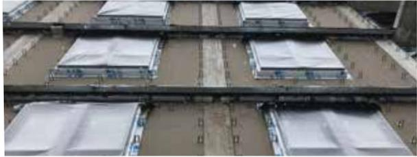
**4.** Installation de la membrane et du solin autour et au-dessus des ouvertures et au niveau de la fondation *(une membrane pleine surface peut être installée, mais n'est pas requise).*
