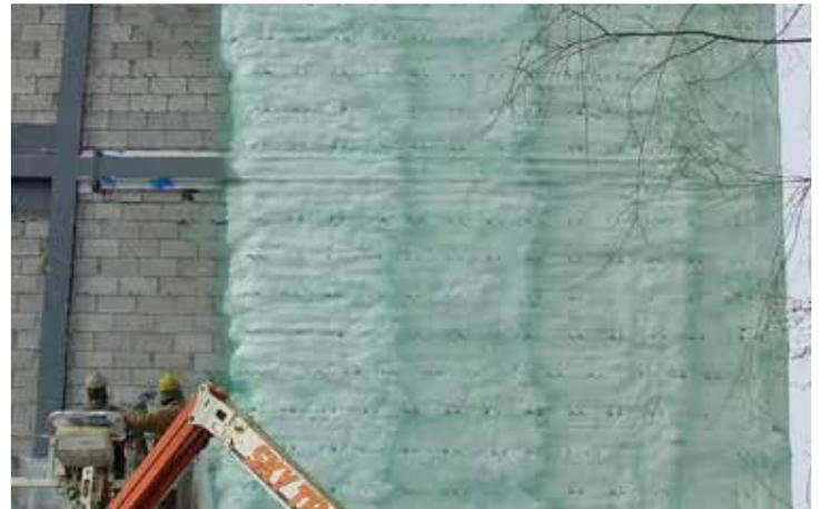
Airmétic Soya HFO installée directement sur un bloc de béton à partir de l'extérieur.
