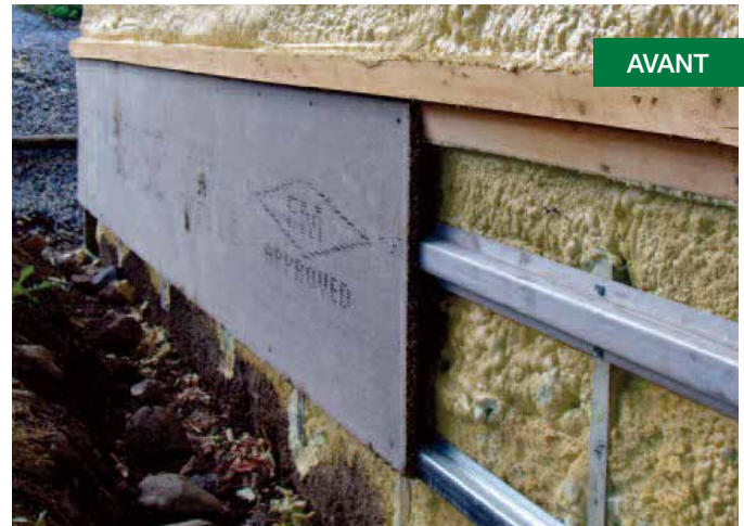
Pendant l'application de la mousse giclée et des barres en Z
