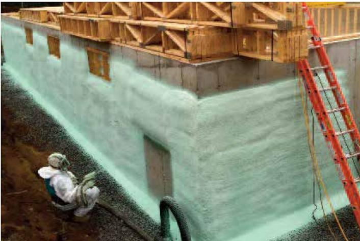
Le moment idéal et la façon la plus efficace d'isoler et d'imperméabiliser la fondation est de le faire par l'extérieur pendant l'excavation d'une fondation existante et avant de remblayer une nouvelle fondation. Cela crée une étanchéité parfaite entre la semelle et le mur.
