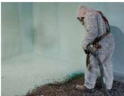
Airmétic Soya HP est évalué comme isolant CCMC-14505-L, matériau pare-air conformément aux normes CAN/ULC S741 et ASTM E 2178 et système pare-air conformément au CAN/ULC S742, surpassant les exigences du CNBC et CCQ ainsi que des produits typiquement utilisés pour cette application.
