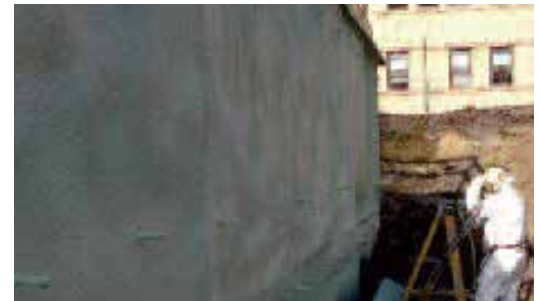
Membrane de drainage qui sera soulevée devant la mousse lors du remblayage du sol.
