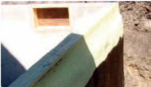
Revêtement bitumineux appliqué directement sur la mousse.
