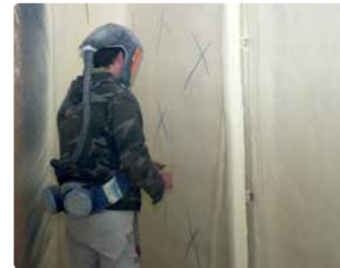
9/ Mur : mesure des épaisseurs
