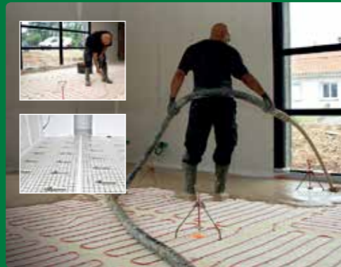
11/ Sol : coulage de la chape de finition
