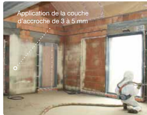
3/ Mur : réalisation de la couche d'accroche
