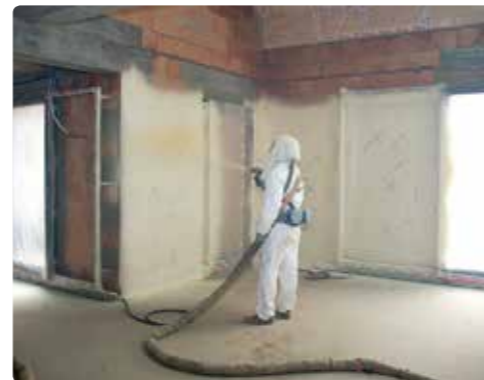
10/ Mur : projection de la couche de finition
