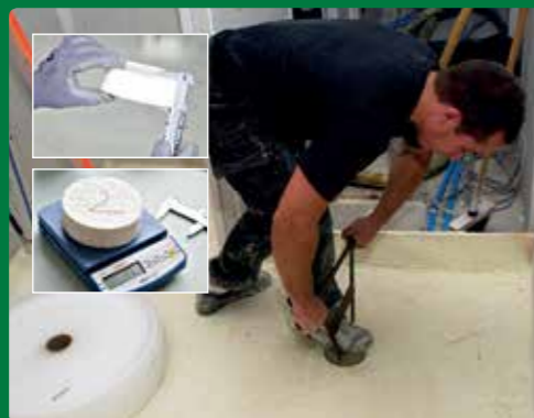
9/ Sol : carottage pour le contrôle CSTB
