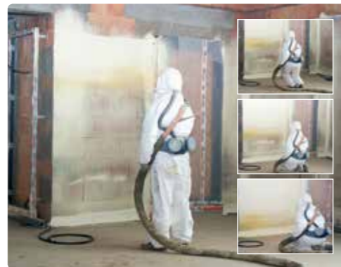
5/ Mur : projection de la 1 ère couche
