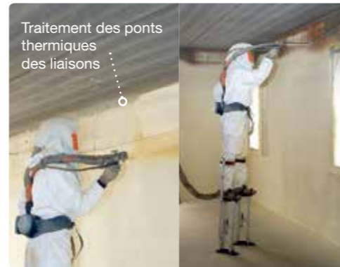
8/ Mur : projection de la partie haute du mur
