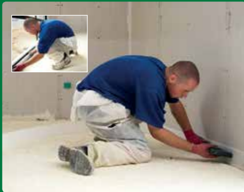
10/ Sol : pose de la bande périphérique
