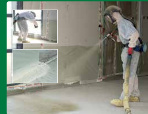
3/ Sol : réalisation de la couche d'accroche
