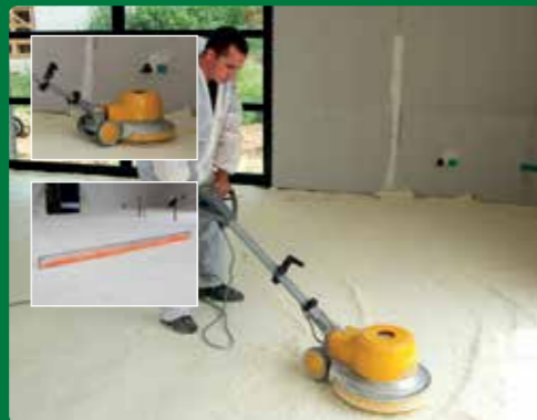
7/ Sol : surfacage par ponçage
