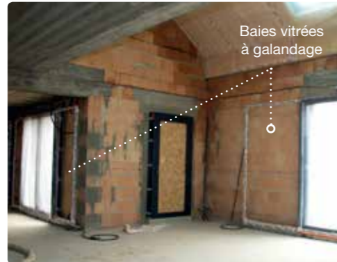
1/ Mur : chantier avant intervention
