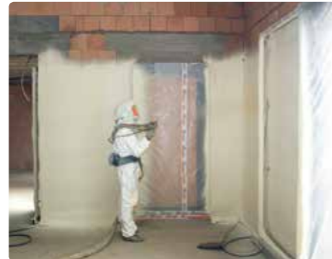
6/ Mur : projection des couches successives
