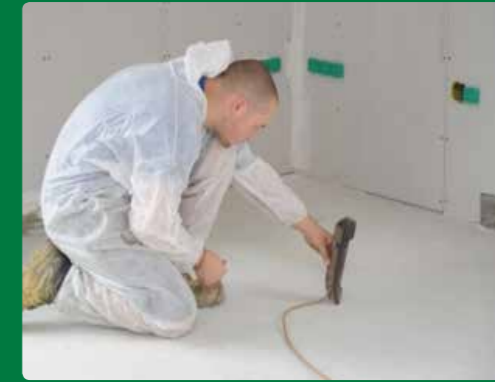
1/ Sol : vérification des niveaux
