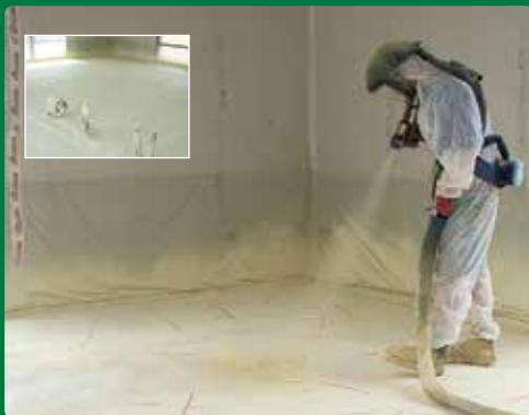
6/ Sol : projection de la couche de finition
