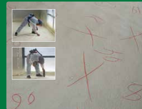
5/ Sol : mesure des épaisseurs
