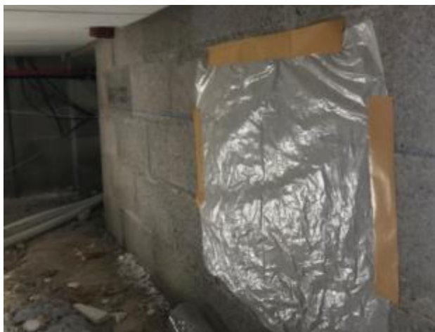
Figure 5 : Protection des orifices de ventilation
