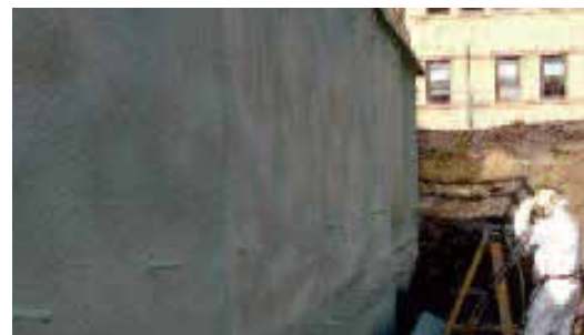
Dräneringsmembran som lyfts framför skummet när jorden fylls på.
