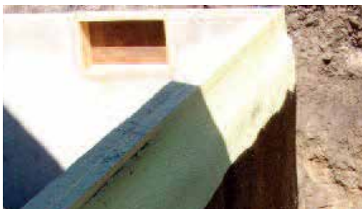
Bituminös beläggning applicerad direkt över skummet.
