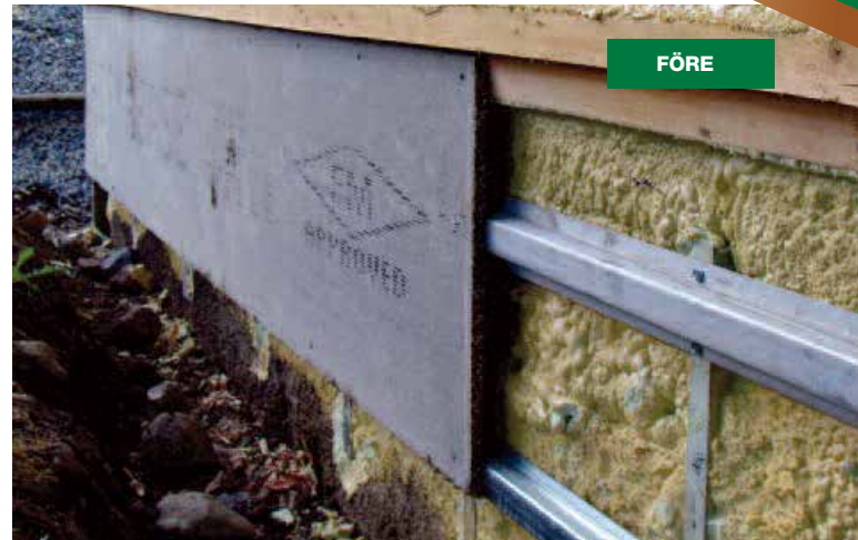
Under applicering av sprutskum och Z-stänger
